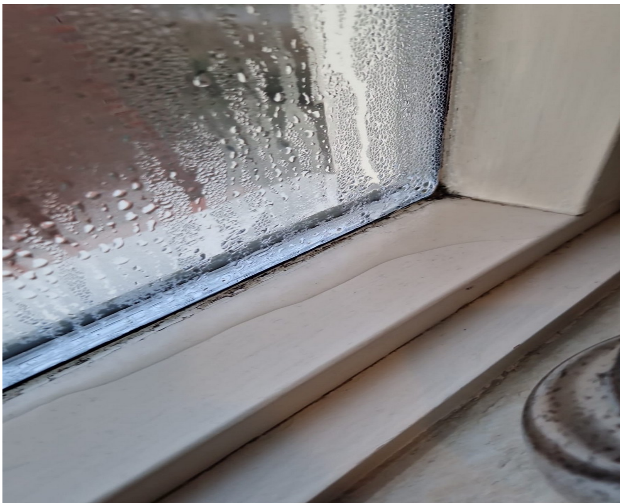
Foto 6. Dubbele beglazing die vochtig wordt
